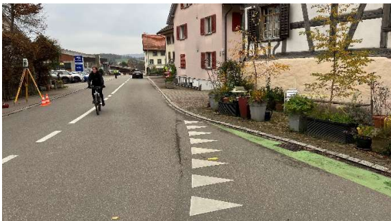
Abbildung 6: Dorfstrasse Richtung Unterschlatt
