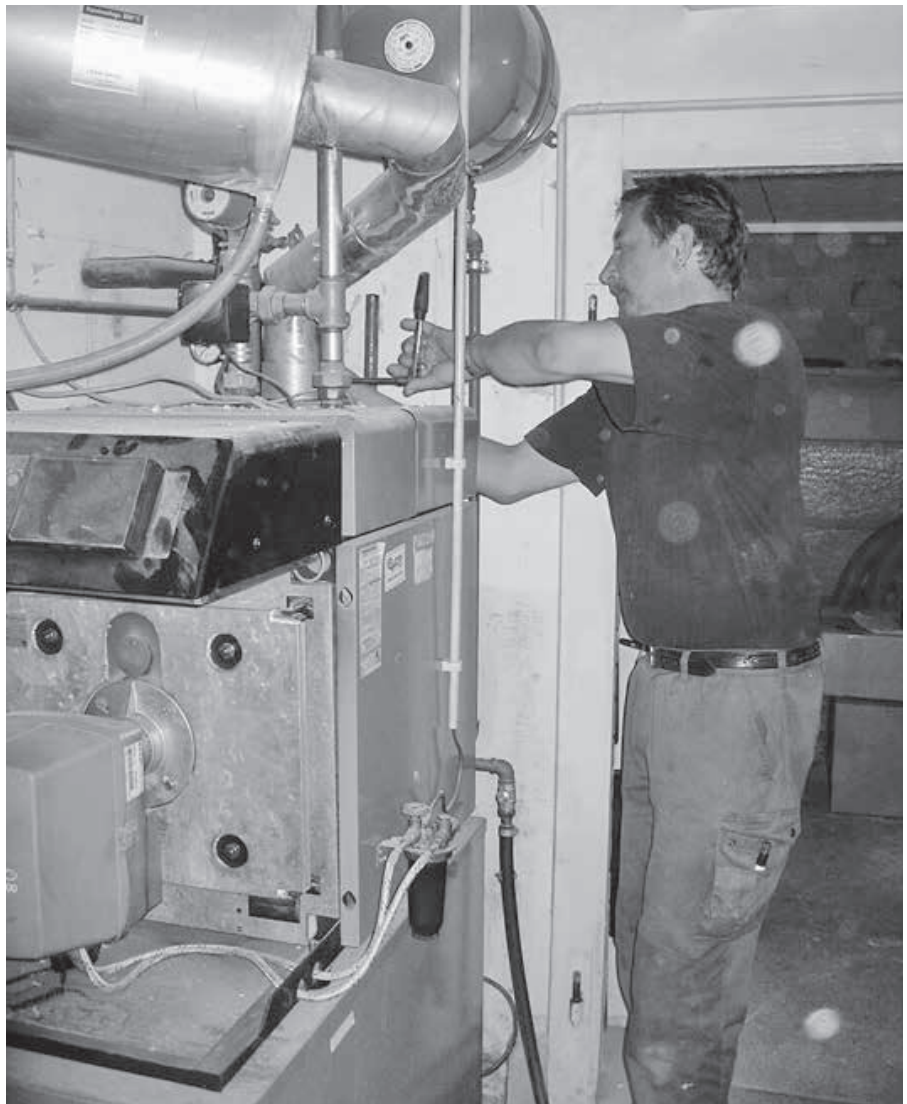
Abbau einer alten Ölheizung (Quelle: Nova Energie, Ettenhausen).
