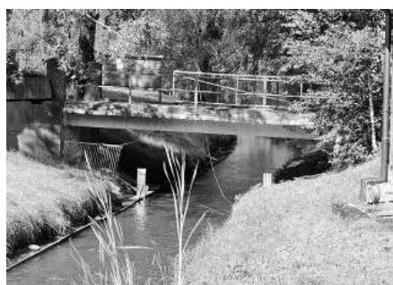
Eine feuerwehrtaugliche und einfach einzurichtende Bachsperre für den Geisslibach, hat der Zivilschutz zusammen mit einem örtlichen Metallbauer eingebaut.
