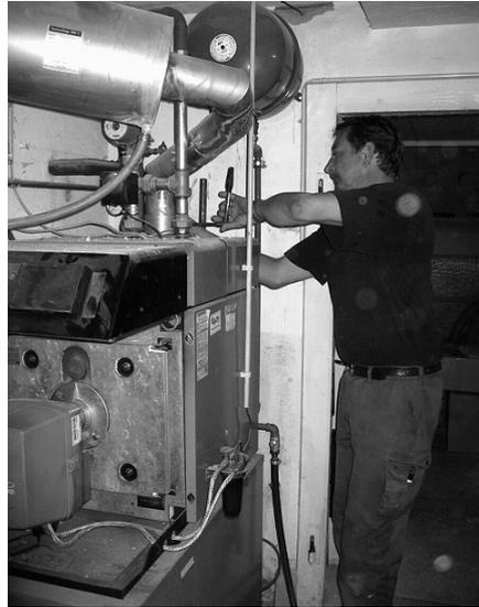
Abbau einer alter Ölheizung (Quelle: Nova Energie, Ettenhausen).
