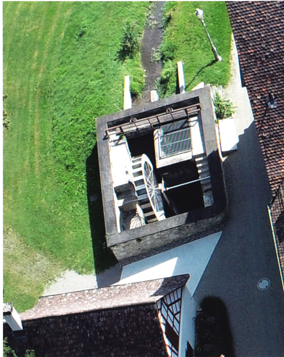
Drohnenfoto von 2023 vom heutigen Zustand des Turbinenbauwerkes. Das Wasserrad hat nur dekorative Funktion und ist ein Geschenk der Schmiedzunft Eligius an die Stiftung Paradies. Die nachfolgend beschriebene Francisturbine befindet sich im mit Gitter abgedeckten Schacht, die Antriebsinstallationen im mit Metall abgedeckten Schacht, rechts vom Turbinenbauwerk. Zwischen der Schmitte und dem Turbinenbauwerk ist die neue Brückenplatte zu erkennen welche im Kapitel Gewölbebrücke beschrieben wird.
