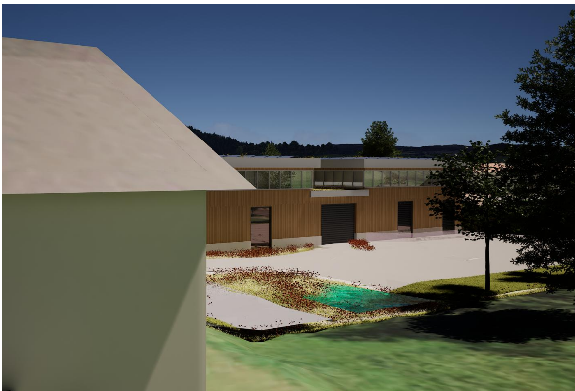
Abbildung 26: Blick aus der nordwestlichen Nachbarschaft nach Südosten. Erkennbar sind der Abstand zwischen den bestehenden Wohnbauten und dem Betriebsareal, die Versickerungsmulde mit ihrer Randbepflanzung nach Art. 14 Abs. 5 SBV sowie die dahinterliegende Rangierfläche. Die Mulde ist im Modell mit Wasserspiegel dargestellt; nach Art. 14 Abs. 3 SBV ist sie als Trockenmulde ohne Dauerstau auszubilden und muss nach dem Bemessungsereignis innert 24 Stunden vollständig leerlaufen.
