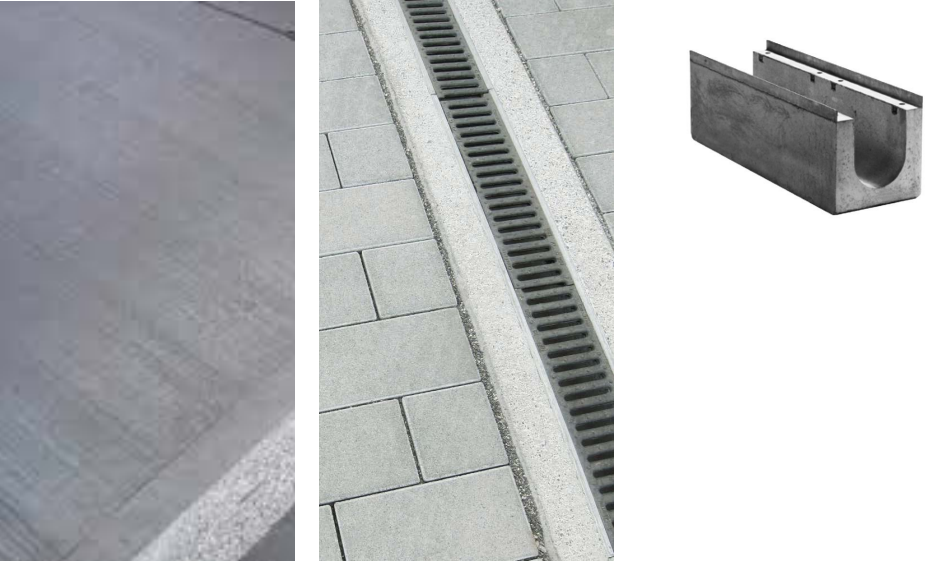
Anlieferung / Manövrierfläche Betriebsgebäude: Betongussbelag & Schwerlastrinnen
