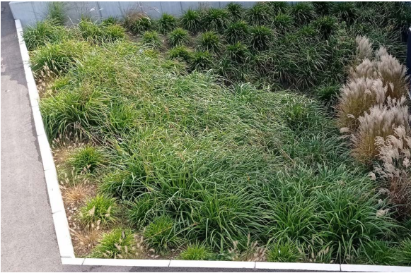
Versickerungsmulde angepflanzt mit Gräser
