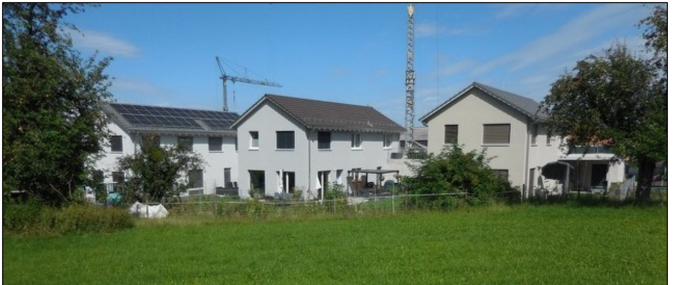
Überbauung «Im Brühl», Parzellen Nrn. 1540 – 1542 (Blickrichtung Ost).
