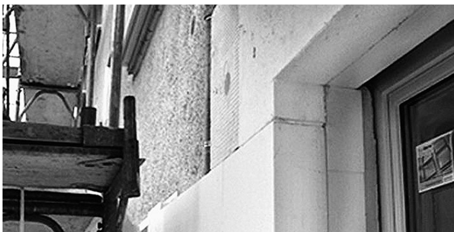
Hauseigentümer profitieren von höheren Förderbeiträgen bei der verbesserten Wärmedämmung von Dach und Fassade.
