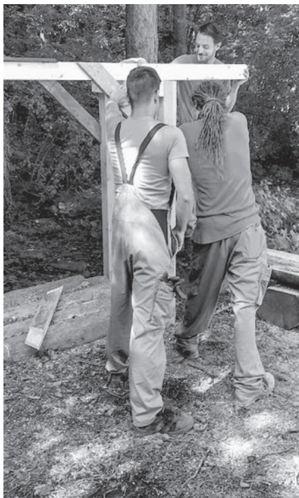
Unterstandes für das Brennholz bei der Schutzhütte «Steig» der Bürgergemeinde Unterschlatt.
